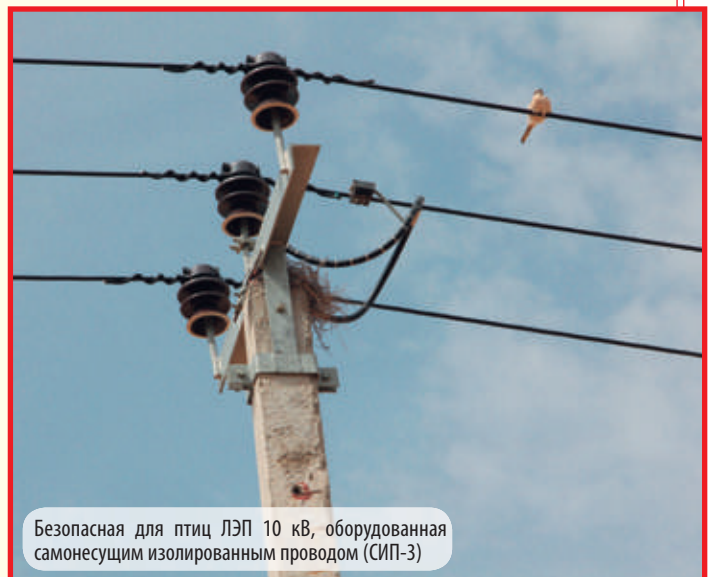
Использование подвесных изоляторов также обеспечивают безопасность птиц, однако лишь в тех случаях, когда расстояние между токонесущими проводами и металлическими траверсами достаточно велико
