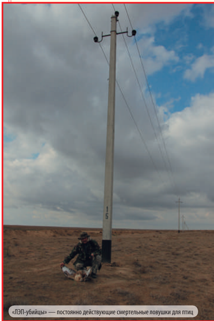
Наиболее опасны для птиц широко распространенные железобетонные опоры ЛЭП с металлическими заземленными траверсами и штыревыми изоляторами
